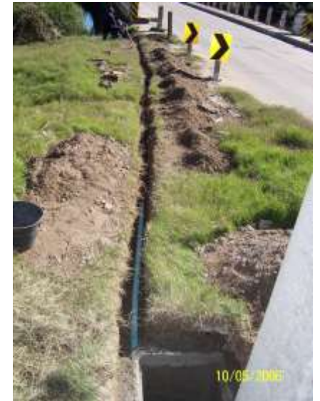
133.0 Santa Lucía. Instalación de la tubería-canalización
